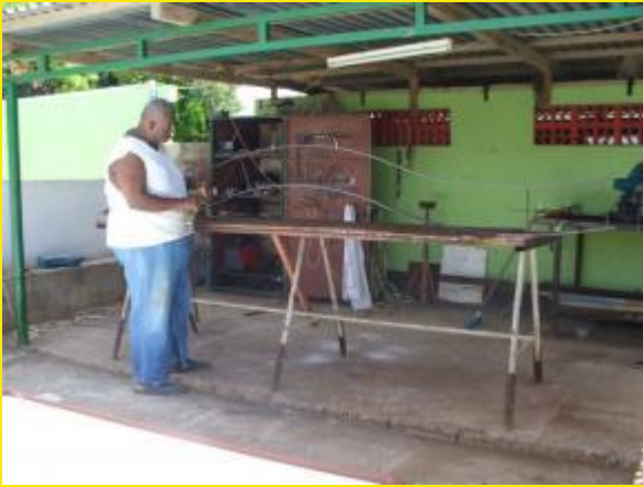
ondertussen vervaardigt de heer Igenia de nieuwe boog voor boven de toegangspoort
