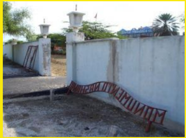
de boog gaat geplaatst worden en de muur krijgt een schilderbeurt
